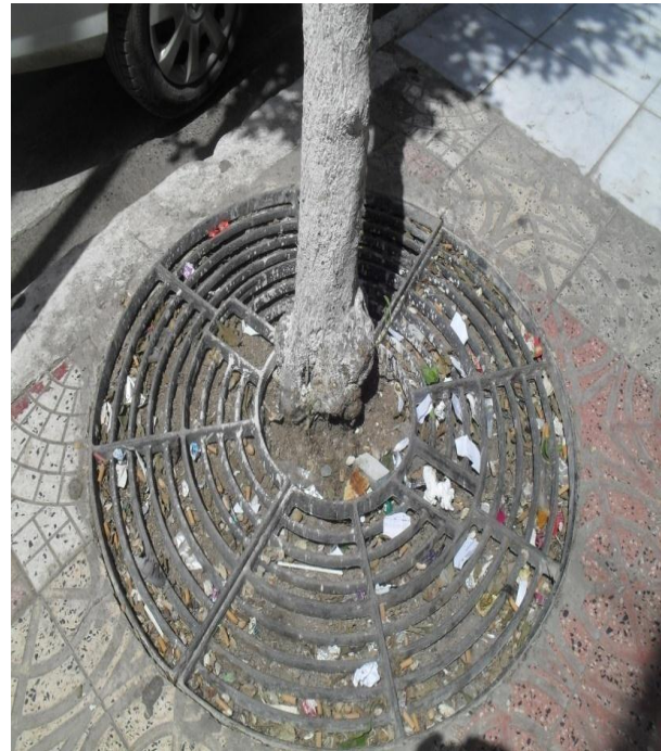
Fig. n° 35 : Grillage de protection. Sétif. (Auteur, 2012)
