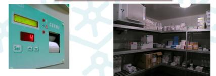
L'utilisation d'un matériel adéquat (chambre froide répondant aux normes avec indicateur de température et sonde d'enregistrement)
